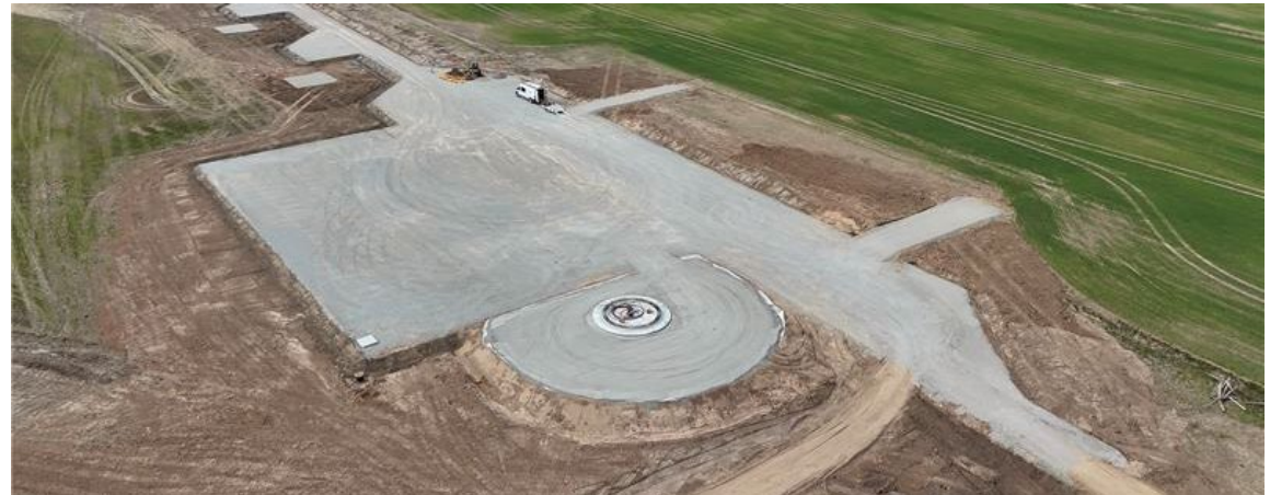
Bilden visar hårdgjord yta och betongfundament vid vindkraftsprojektet Pienava (147 MW) i Tukums kommun i Lettland. Projektet gick in i etableringsfas i samband med försäljningen till Latvenergo i juli 2025 och väntas stå färdigt 2027.
