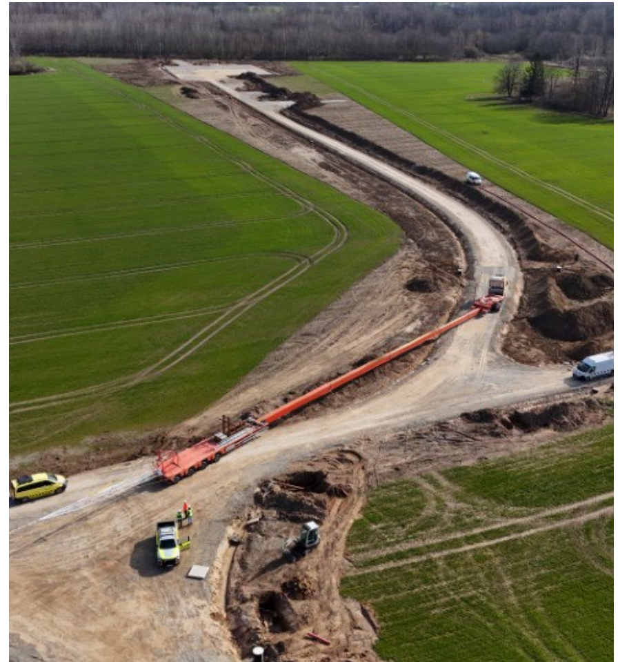
Leverans av en byggkran till vindkraftsprojektet Pienava (147 MW) i Tukums kommun i Lettland. Projektet gick in i etableringsfas i samband med försäljningen till Latvenergo i juli 2025 och väntas stå färdigt 2027. Eolus tillhandahåller projektledningstjänster för byggnationen till köparen Latvenergo.
