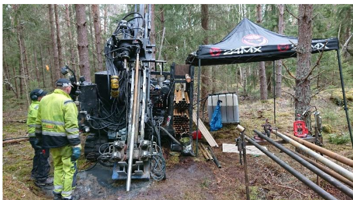
Pågående borrning av det östra hålet
