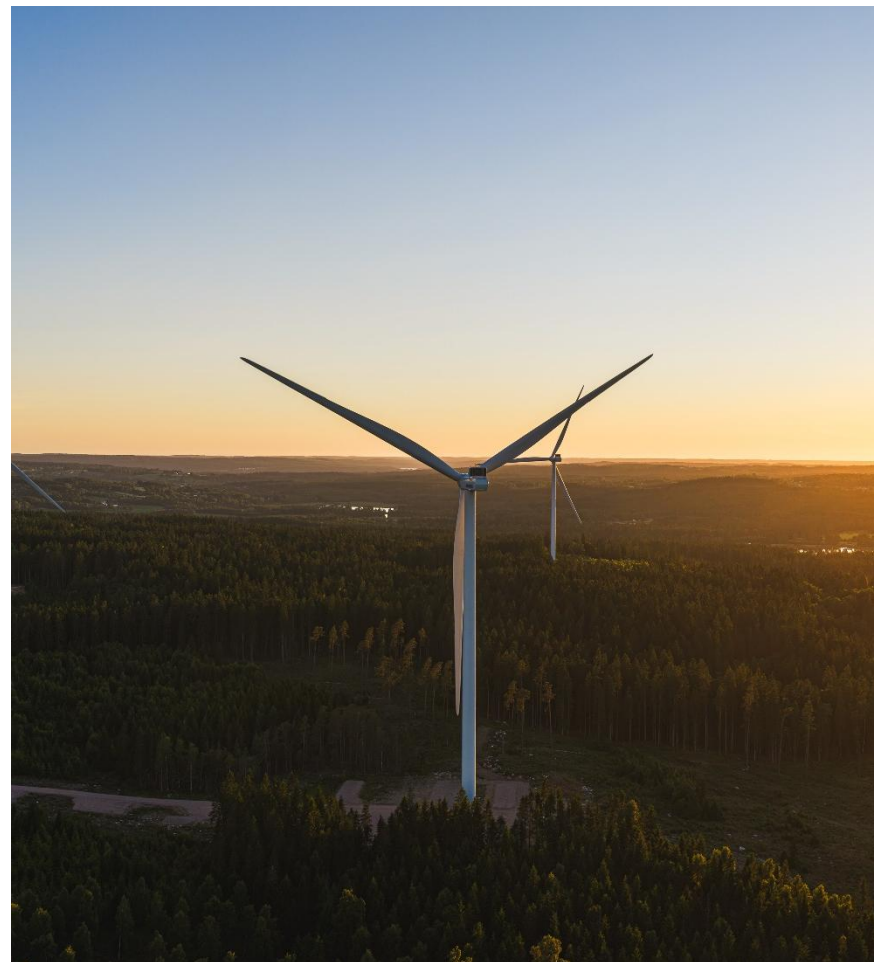
Vindpark Dällebo i Ulricehamns kommun omfattar fyra verk om totalt 18 MW. På uppdrag av ägaren Mirova utvecklar Eolus nu batterilager för såväl Dällebo som vindparkerna Fågelås och Boarp.
