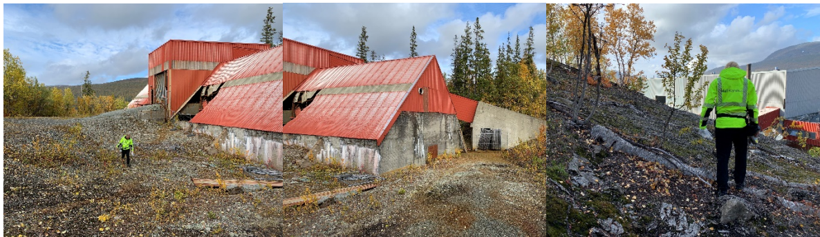
Figur 5-15: Området utenfor råmalmsilo. Venstre: hovedinngang for lastebiler, med vei og snuplass. Midten: vei ned til båndsjakt, og inngangsparti til båndsjakt. Høyre: skogsområde nedenfor råmalmsilo/ovenfor kontorbygg og oppredningsverk.
