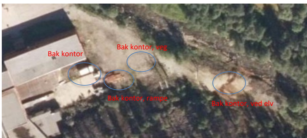
Figur 5-7: Flyfoto over administrasjonsbygget og arealet bak. Blå sirkler markerer områder for XRF-målinger.
