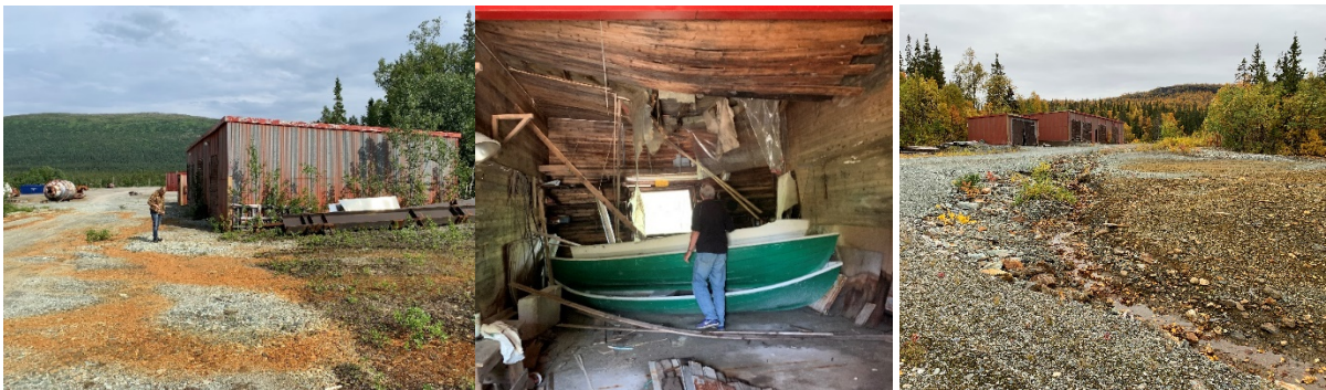
Figur 5-14: Til venstre og midten: Snekkerverksted utvendig og innvendig. Høyre: Prøvetatt sig, som blant annet drenerer arealet ovenfor snekkerverksted.
