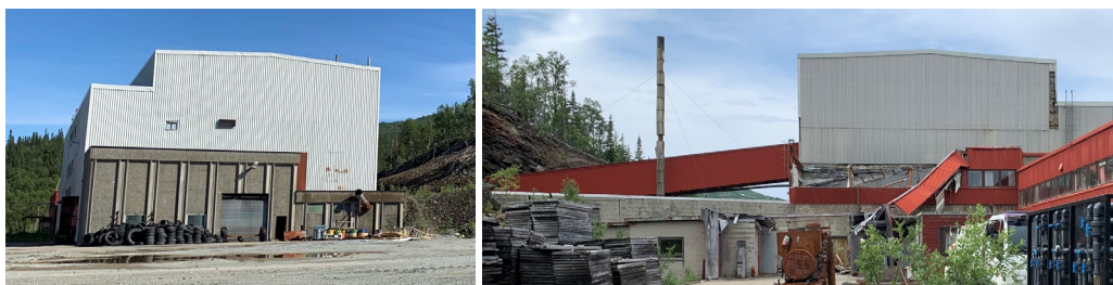
Figur 3-1: Bilder av eksisterende industribygg for oppredningsverket. Bru fra silo i fjellet vises på bildet til høyre.
