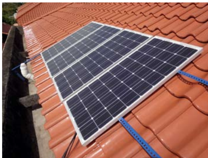
Renewable Ventures Nordic har nyligen investerat i ett bolag inom solenergisektorn.
