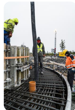
Byggnation av vindpark Jenåsen.
