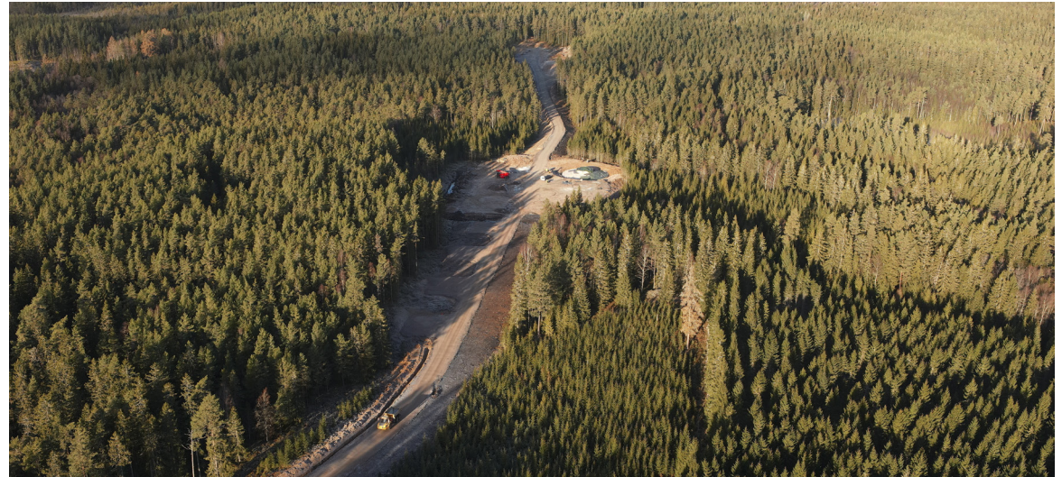
Byggnation av vindpark Fågelås i Hjo. Projektet omfattar sju vindkraftverk med totalt 45 MW installerad effekt.
