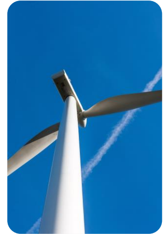
Vindpark Gunillaberg i Jönköpings kommun.
