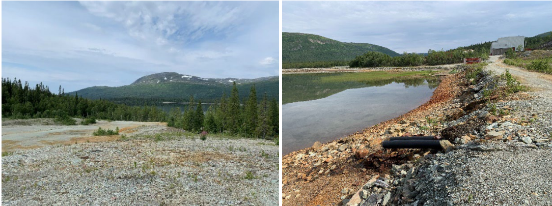
Figur 2-8: Bilde til venstre: Gråbergstipp. Austre Hudningsvatnet skimtes i bakgrunnen. Bildet til høyre: Oppredningsverket i bakgrunnen, og strandkanten på Austre Hudningsvatnet i forgrunnen.
