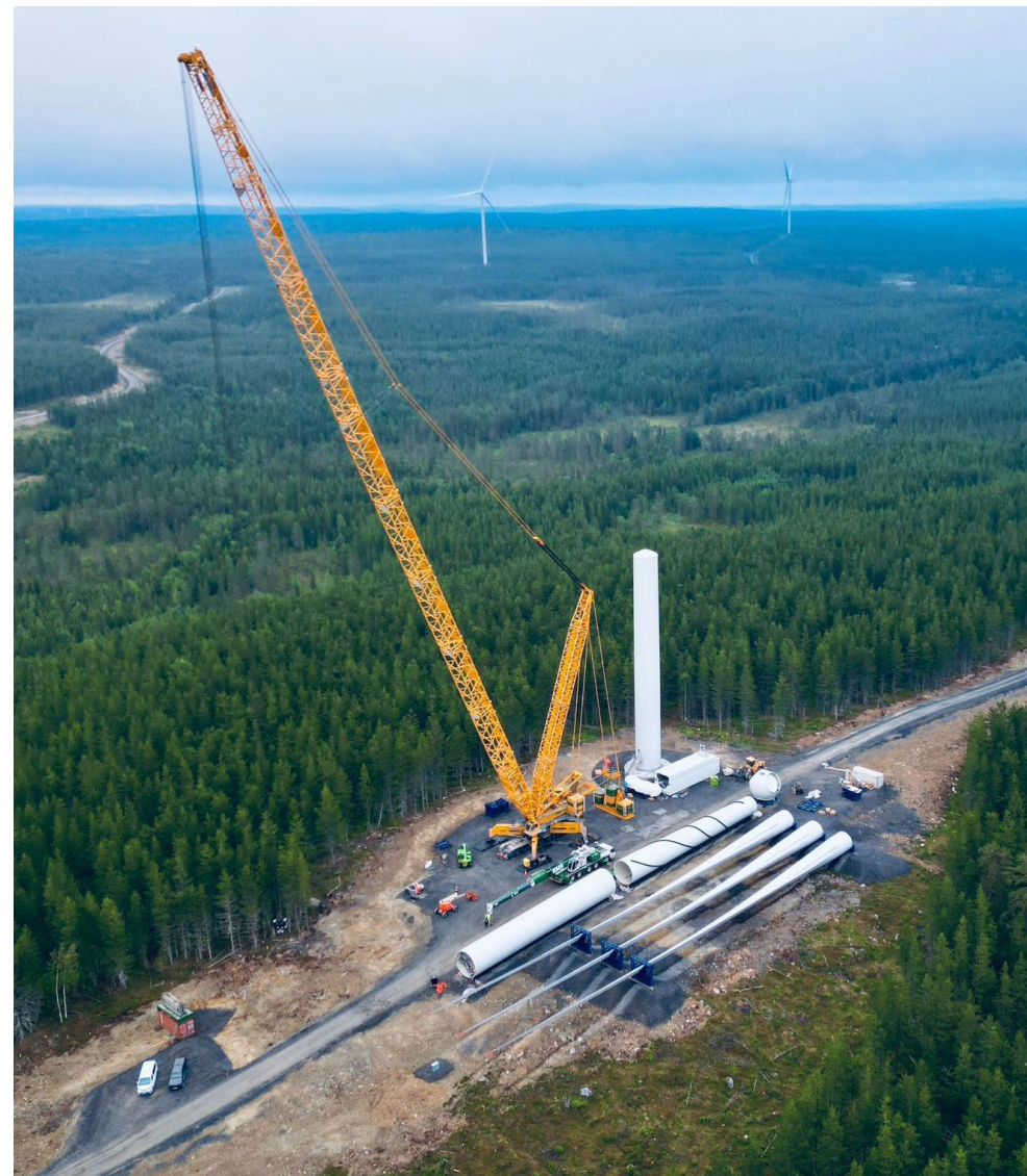
Byggnation av projekt Stor-Skälsjön i Sundsvall med 42 vindkraftverk och totalt 260 MW installerad effekt.
