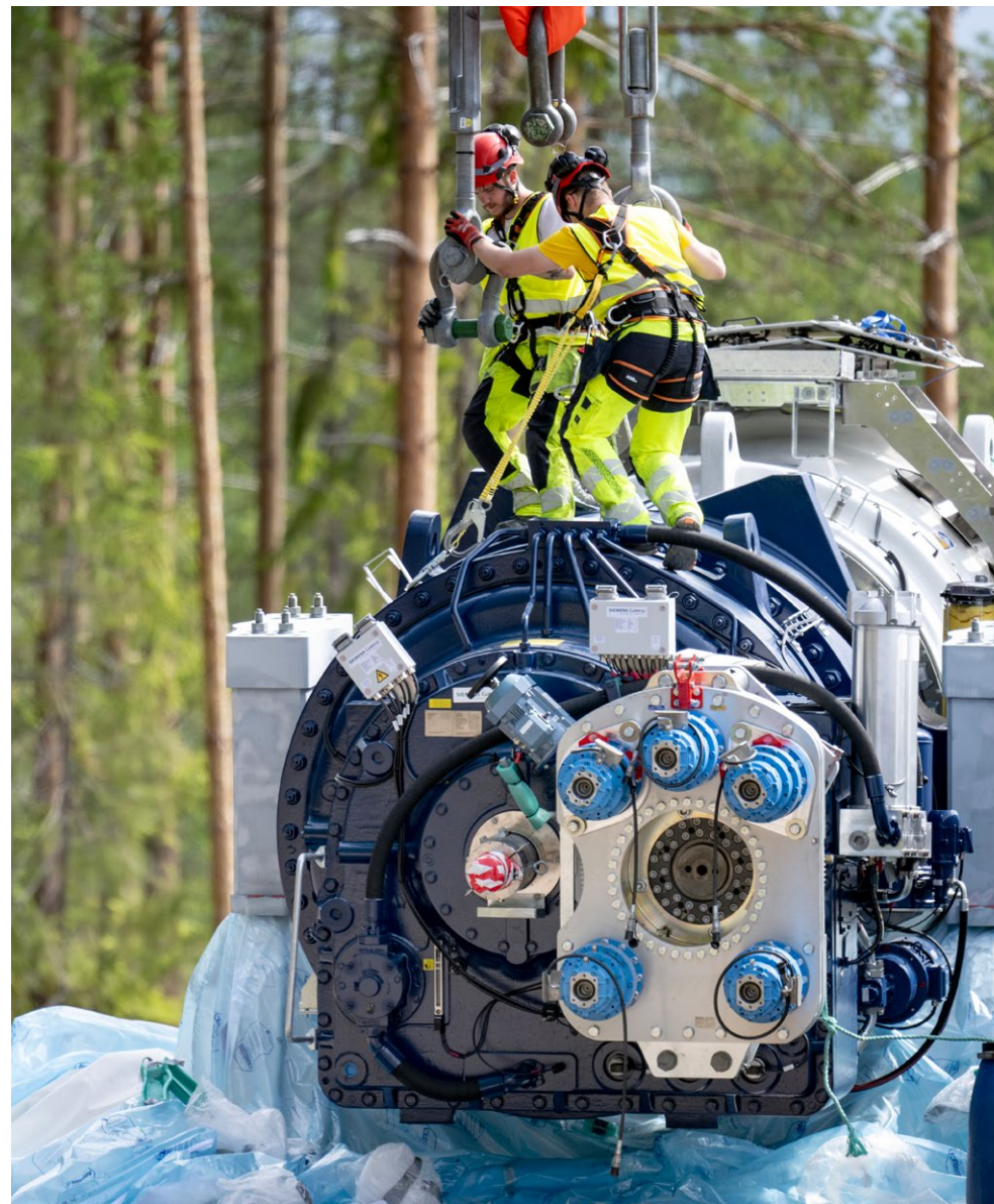
Eolus har starkt fokus på säkerhetsarbetet på de anläggningar där vi leder byggnationen, vilket oftast sker genom byggningsavtal med ägaren av projektet.
