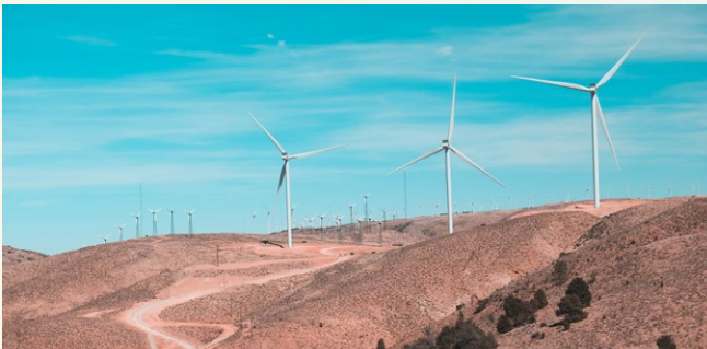
Wind Wall är ett repoweringprojekt i Kalifornien som Eolus färdigställde 2021. Vindparken levererar el till Amazon via ett mångårigt PPA.
